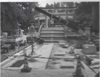
多賀神社（多賀町）平成の大造営での正面参道の敷石工事
