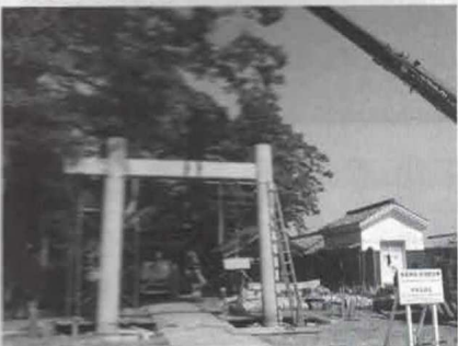
鳥居の移設修復工事（地元・菅原神社）
